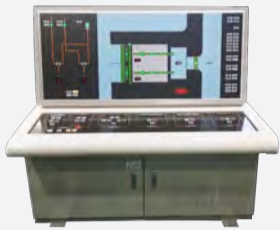
遠隔操作監視盤
