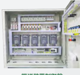
搬送装置制御盤
